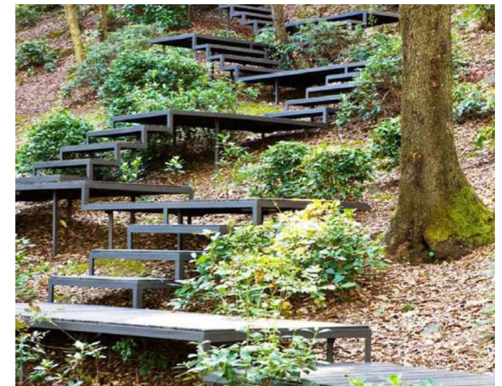
LÁVKY - MODŘÍNOVÉ DŘEVO
