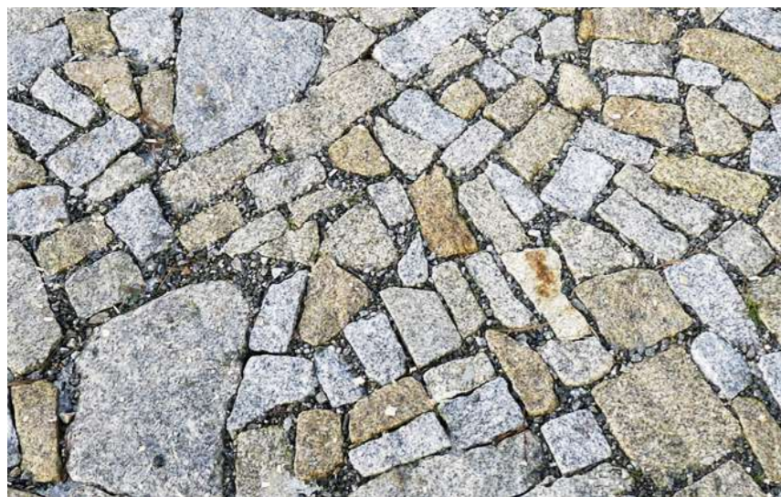
DLAŽBA (ŽULOVÝ ODSEK) - HLAVNÍ PŘÍSTUPOVÁ CESTA K OBJEKTŮM
